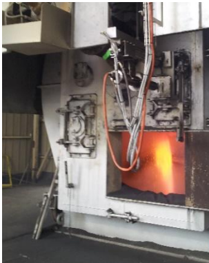
Infrarotkamera PYROINC 380LF mit Luftspülung, Wasserkühlung und Notrückzugvorrichtung
