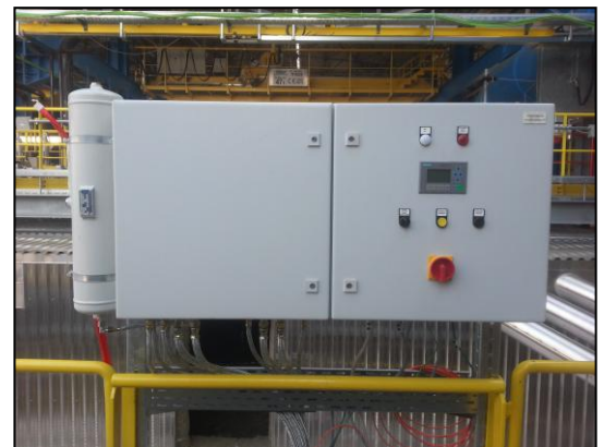
IR-Kamera mit vollautomatischer Ein- und Ausfahreinheit sowie Schaltschrank. Einbauort: Kesseldecke
